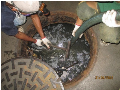
การทำความสะอาดและดูตะกอน
