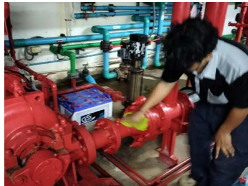
ตรวจเช็คเครื่องสูบน้ำดับเพลิง
